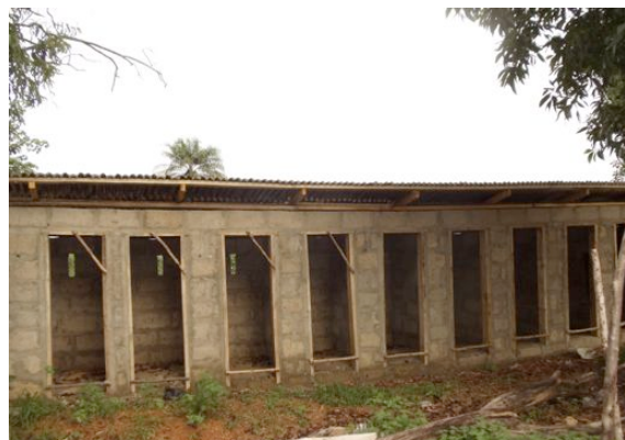
De tien toiletten in aanbouw
